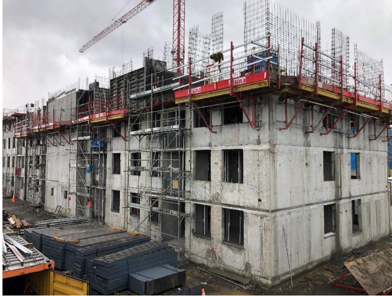
Imagen 7: Obra Gruesa Torre B.
